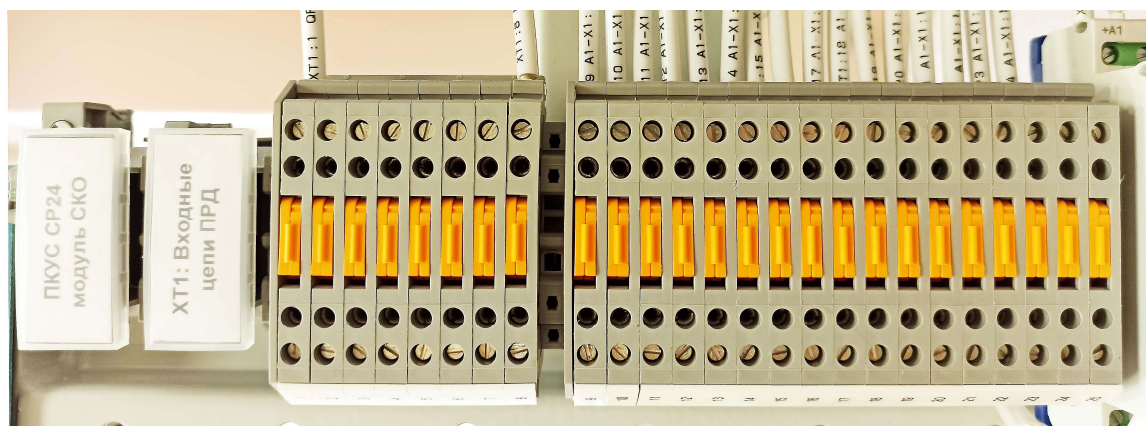
Рис. 8.5 Подключение входов дискретных сигналов команд на клеммах шкафа
