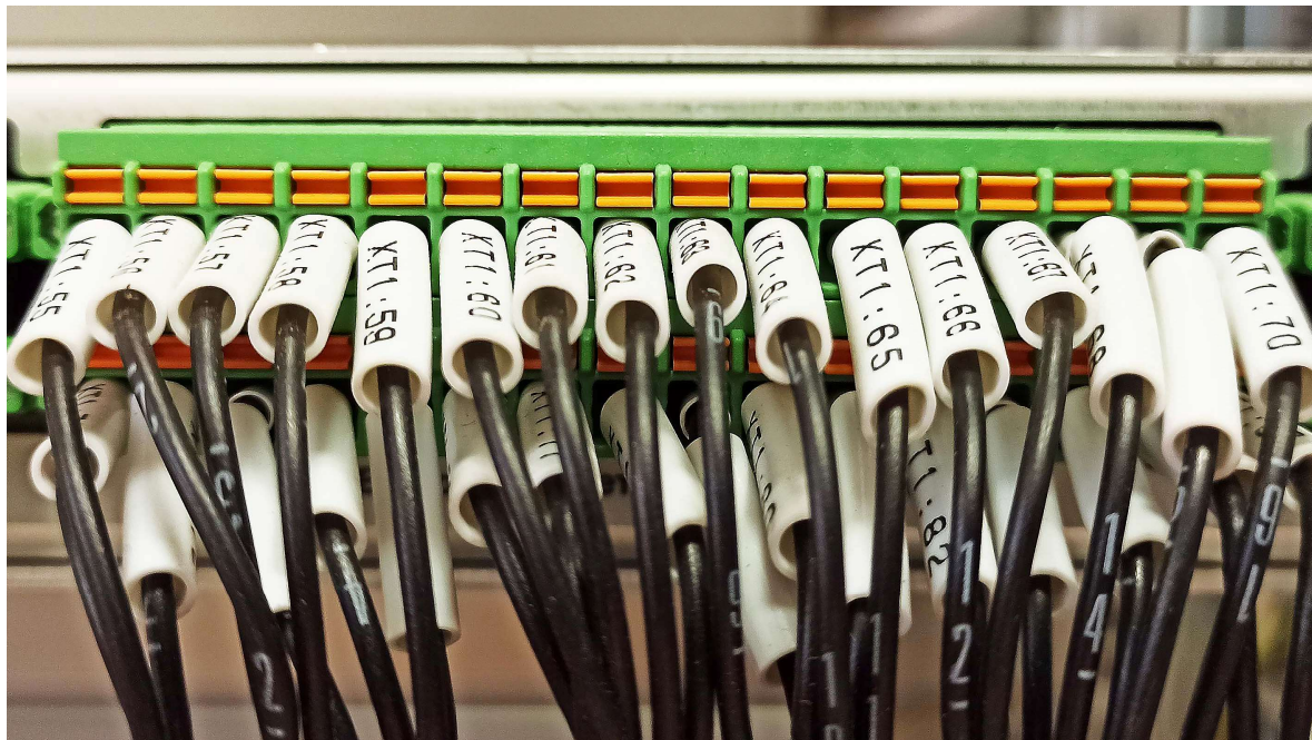
Рис. 8.6 Подключение выходов дискретных сигналов команд на ПКУС СКО
